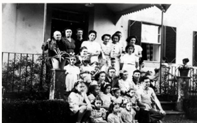
Refugiados à entrada do Hotel na Camacha
